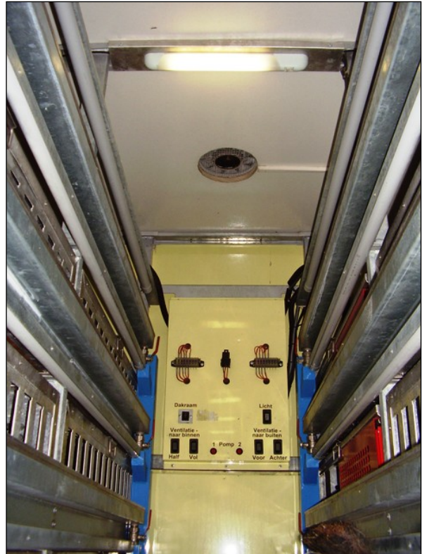
f. Achterzijde wagen met dakventilator (610 m 3 /h) in plafond
